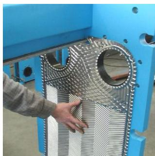
Рис 6.11. Монтаж первой пластины
